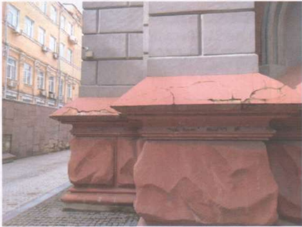
Фото 14. Фасади. Те саме.
