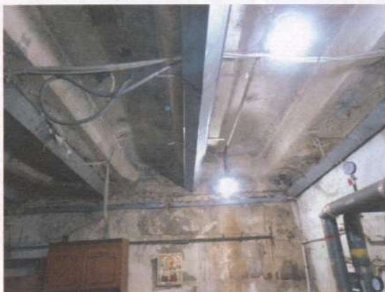
Фото 11,12. Технічні приміщення. Затікання, цвіль, сталактити на стелі. «Нова» технологія водовідведення – підвісними лотками з середини. Корозія бетону та арматури плит перекриття. Корозія електропроводів, систем електропостачання, водопостачання та опалення.
