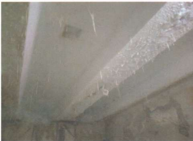
Фото 27, 28. Підвал. Технічне приміщення. Як у печері на стелі краплі мінеральної води, вимиваючи вапно з бетону, утворюють мінеральні виступи — сталактити, що обумовлює корозію бетону та арматури.
