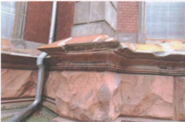
Фото 8. Фасади. Те саме.
