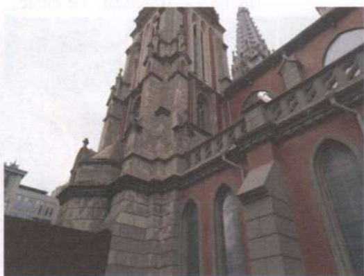
Фото 82. Фасади. Те саме.
