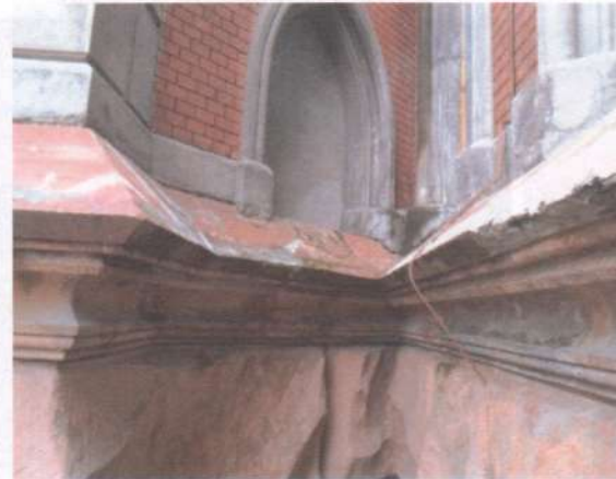
Фото 56. Фасади. Те саме.
