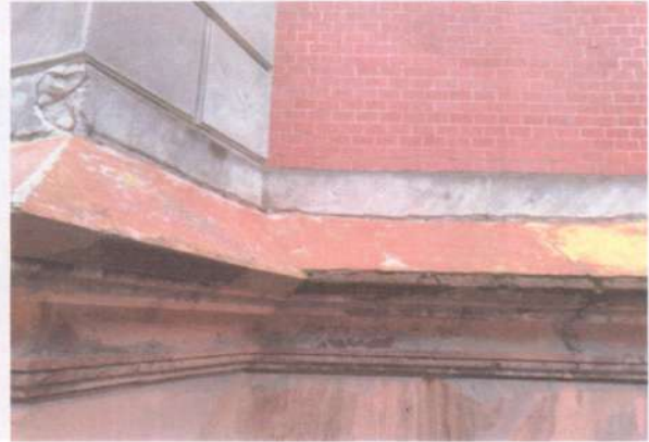
Фото 45. Фасади. Те саме.
