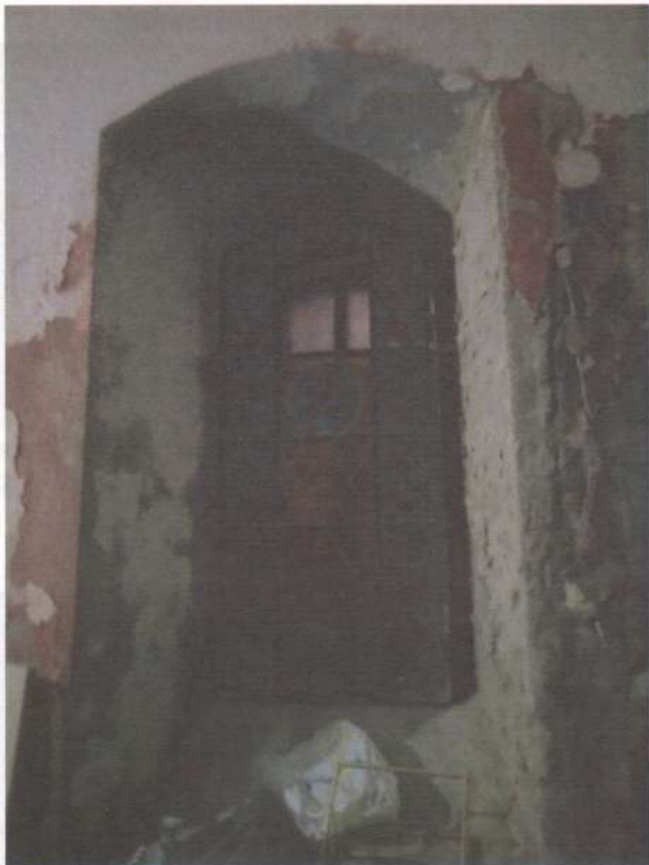
Фото 9,10. Підвал. Під головним вітварем. Без вентиляції у вологих умовах протягом десятиліть корозія бетону, арматури та електропроводів. Пліснява, тріщини штукатурки, оздоблення та їх осипання.
