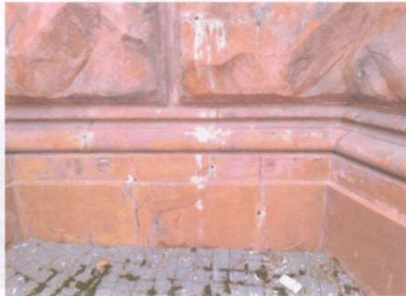
Фото 47. Фасади. Те саме.
