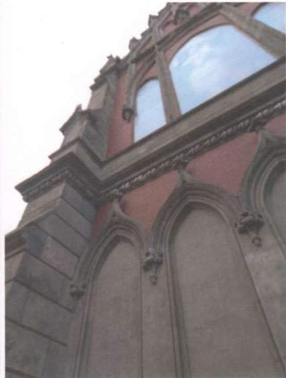
Фото 85. Фасади. Те саме.
