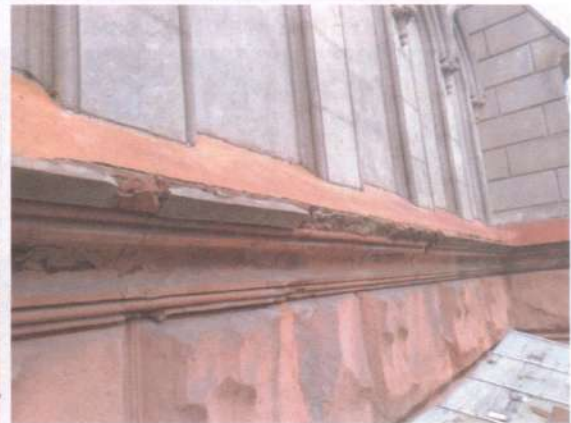
Фото 41. Фасади. Те саме.
