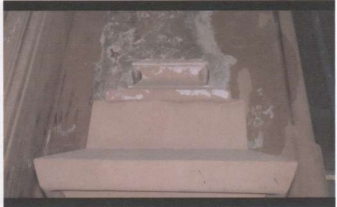
Фото 17, 18. Оздоблення поверхні всіх колон потріскалось, відшаровується та осипається. Місцями штукатурка та бетон потріщали та є випадання кусків бетону тощо.
