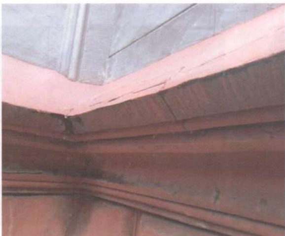
Фото 28. Фасади. Те саме.
