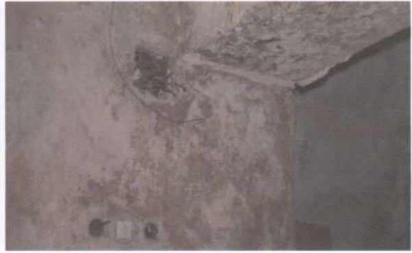
Фото 23, 24. Підвал. Канали вентиляційних систем не працюють. Корозія арматури.
