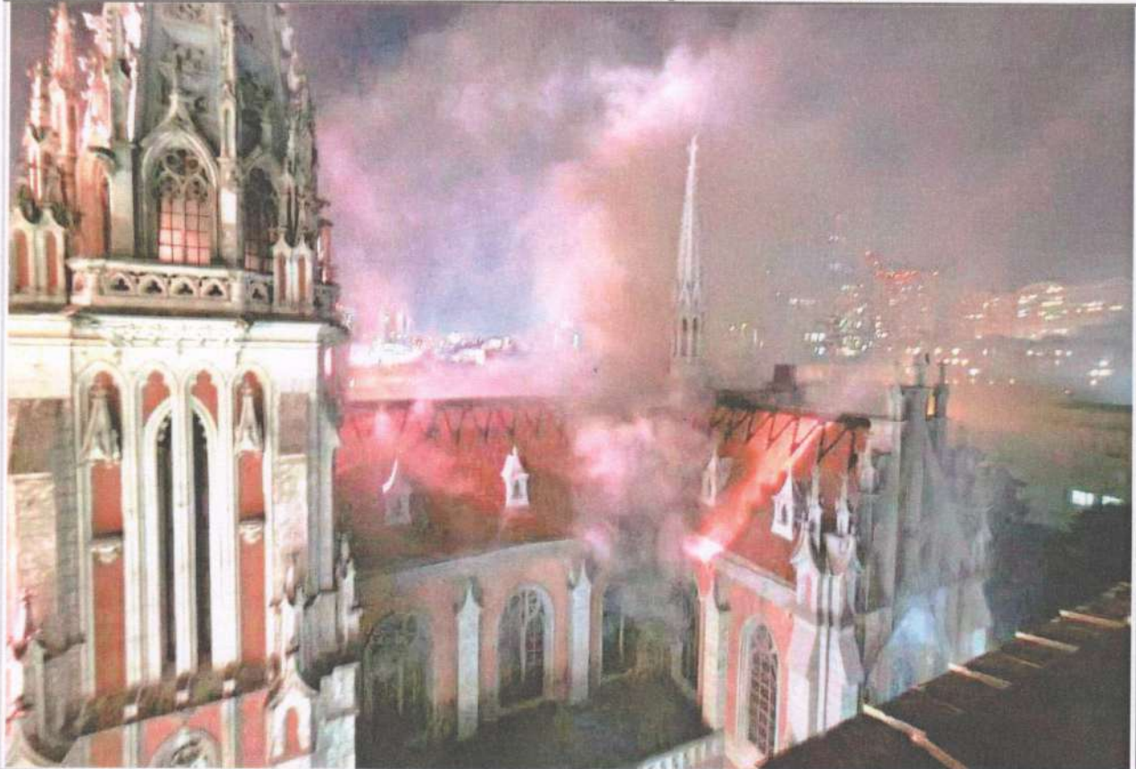
Пожежа виникла на рівні 1-го яруса. Густих дим з вікон 2-го яруса південного трансепта та з рівня горіща костелу. Вертикальне розповсюдження фронту вогню будівлею через вільний доступ свіжого повітря до зони горіння та утворення тяги з перепадами тиску на висоті до 25 м. Відсутня можливість використання пожежної завіси сцени, димовидалення, пожежних перепон та ін. засобів локалізації та боротьби з вогнем через невідповідність будівлі вимогам I
