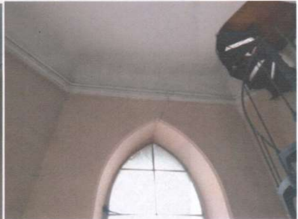
Фото 24, 25. Конструкції другого поверху. Перекриття стрілчатих вікон у найвищій (найслабшій) частині, можливо через дії динамічних навантажень при русі потягів метрополітену, мають тріщини, руйнуються і потребують підсилення.
