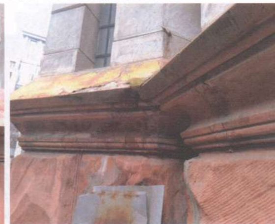
Фото 51. Фасади. Те саме.
