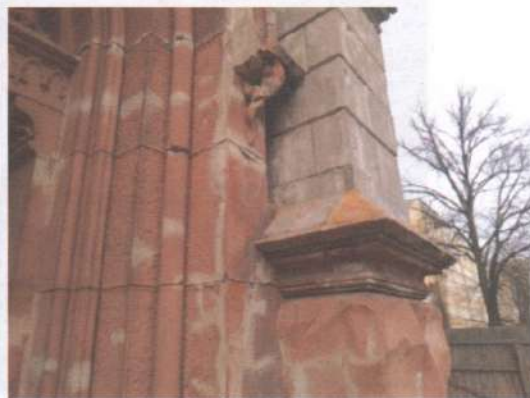
Фото 69. Фасади. Те саме.
