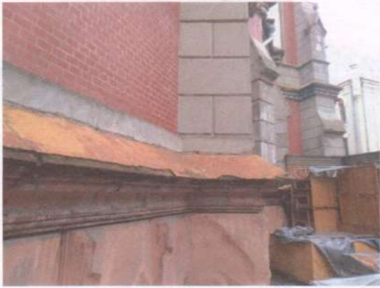
Фото 36. Фасади. Те саме.
