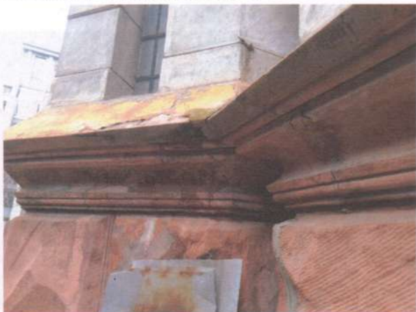
Фото 18. Фасади. Те саме.
