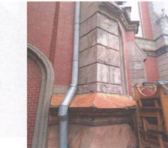
Фото 58. Фасади. Те саме.
