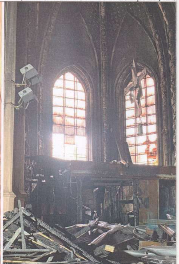
Східна апсида костелу Св. Миколая з органом оприс #3503 до та після пожежі 03.09.2021 р. Всі дерев'яні та металеві аерофони і повітропроводи інструменту знищені вогнем. В зразках розплавлених зон займання, частки металів досягають (див. протоколи, дод. 12): • у внутрішньому металі труб цинк Zn~99,1032%, свинець Pb~0,7904% ( t_{\text{плавл.}} = 318+418^{\circ}\text{C} ) • у зовнішньому металі труб олово Sn~72,9982%, свинець Pb~26,9567% ( t_{\text{плавл.}} = 183+198^{\circ}\text{C} ) • у металевому розплаві (шламі) олово Sn~68,7025%, свинець Pb~31,2673% ( t_{\text{плавл.}} = 183+193^{\circ}\text{C} )
