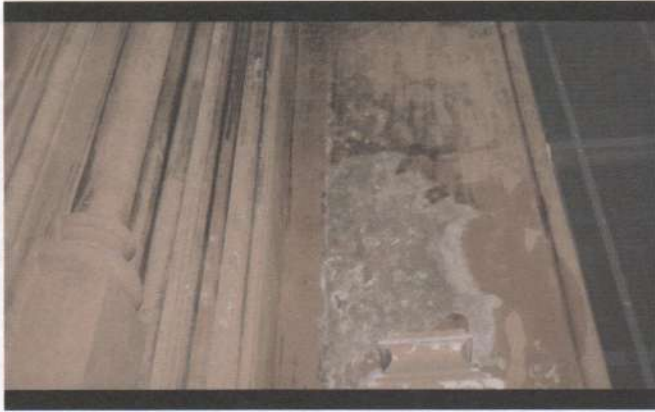
Фото 9, 10. Оздоблення поверхні всіх колон потріскалось, шелушиться та осипається. Місцями штукатурка та бетон потріщали та є випадання кусків тощо.
