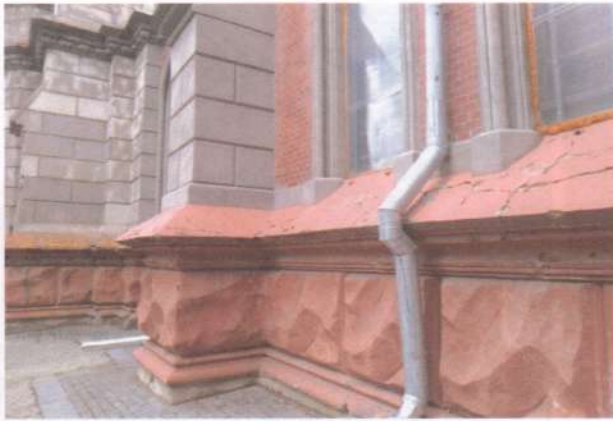
Фото 12. Фасади. Те саме.
