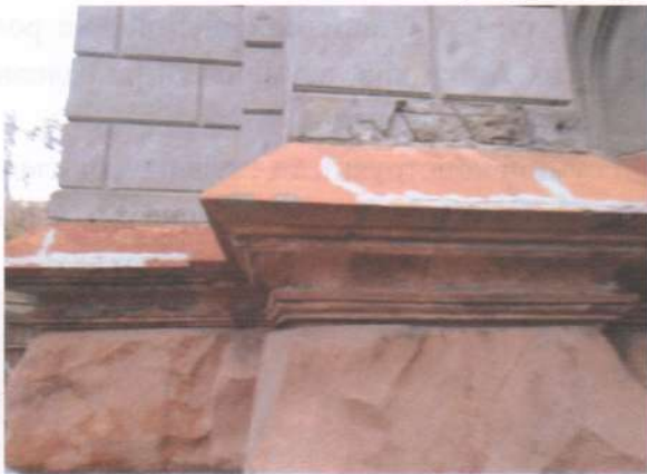
Фото 6. Фасади. Те саме.
