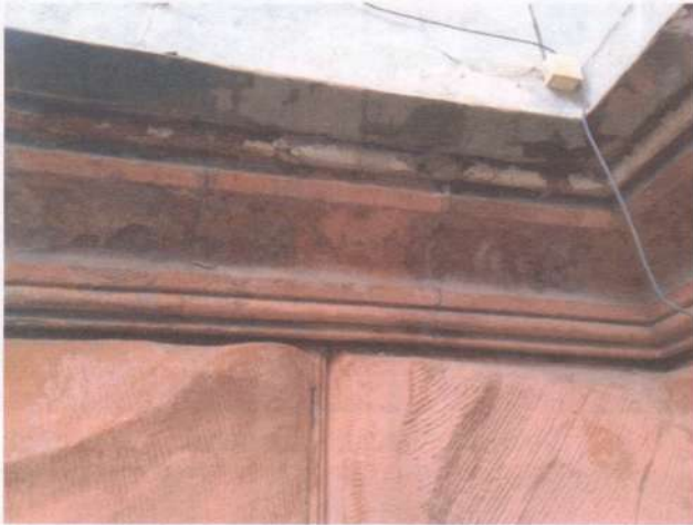
Фото 20. Фасади. Те саме.
