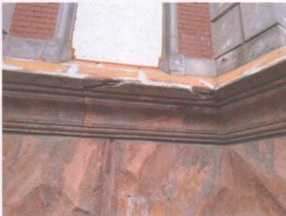
Фото 49. Фасади. Те саме.
