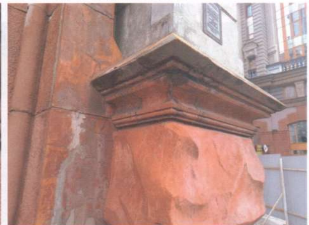
Фото 19. Фасади. Те саме.
