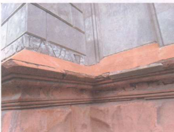
Фото 42. Фасади. Те саме.
