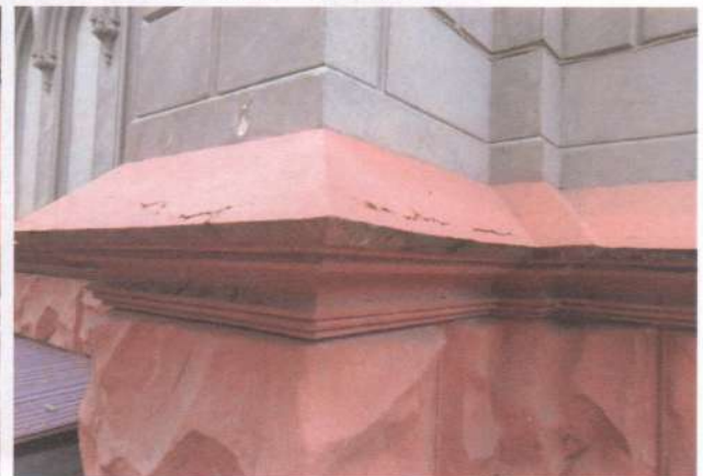
Фото 27. Фасади. Те саме.
