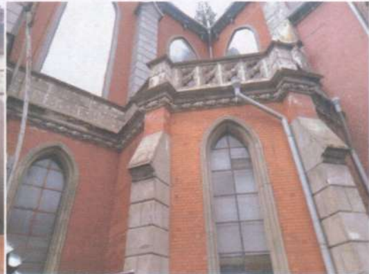
Фото 75. Фасади. Те саме.
