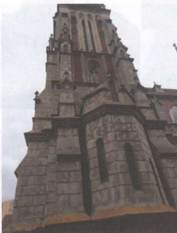
Фото 80. Фасади. Те саме.
