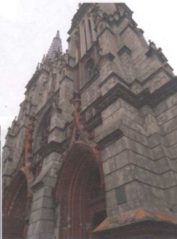
Фото 83. Фасади. Те саме.
