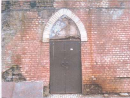
Фото 8, 9. Технічні приміщення. Руйнування фасадів обумовлене низькою якістю використаних матеріалів та відсутністю захисту від дії природних чинників.
