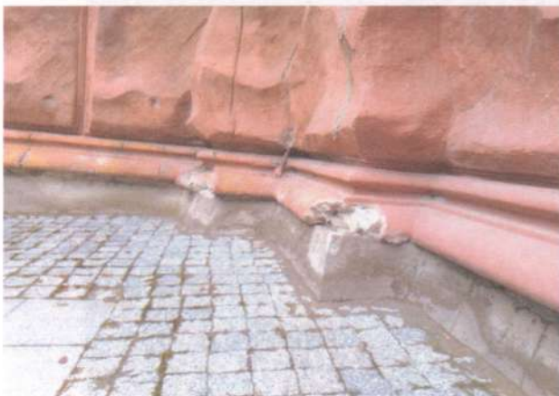
Фото 10. Фасади. Те саме.
