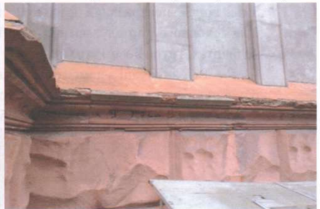
Фото 7. Фасади. Те саме.
