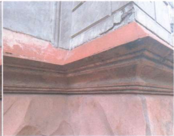
Фото 39. Фасади. Те саме.
