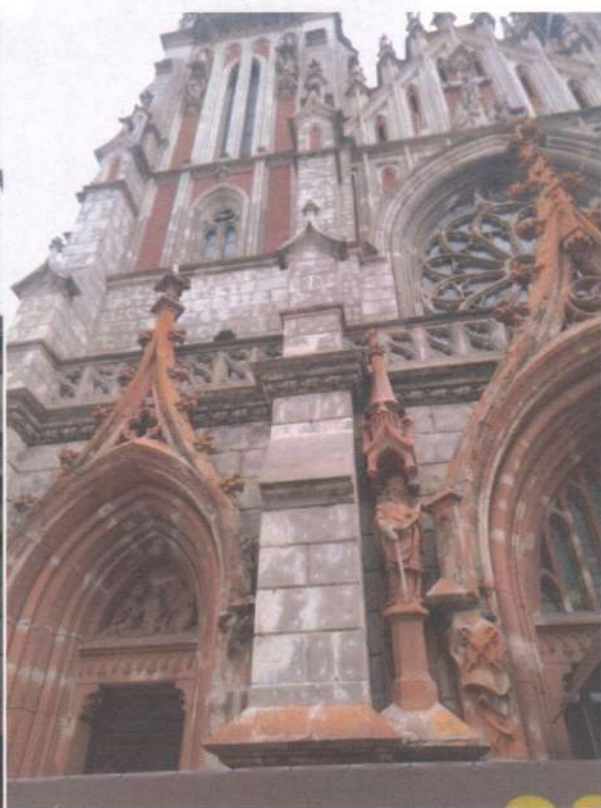
Фото 81. Фасади. Те саме.
