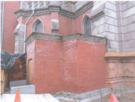
Фото 46. Фасади. Те саме.
