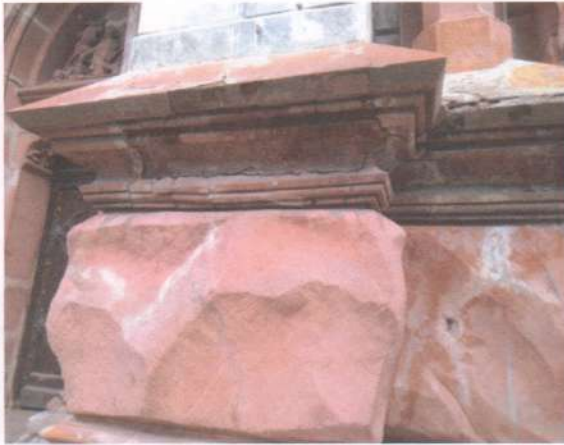
Фото 52. Фасади. Те саме.
