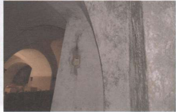
Фото 15,16. Підвал. Приміщення гардеробу . У вологих умовах без вентиляції стіни вкриті шарами плісняви, штукатурка та оздоблення потріщали та осипаються.
