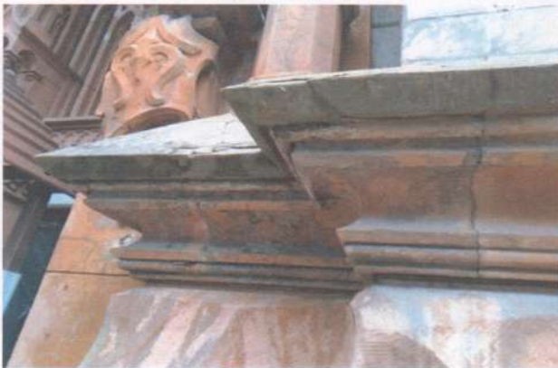
Фото 24. Фасади. Те саме.
