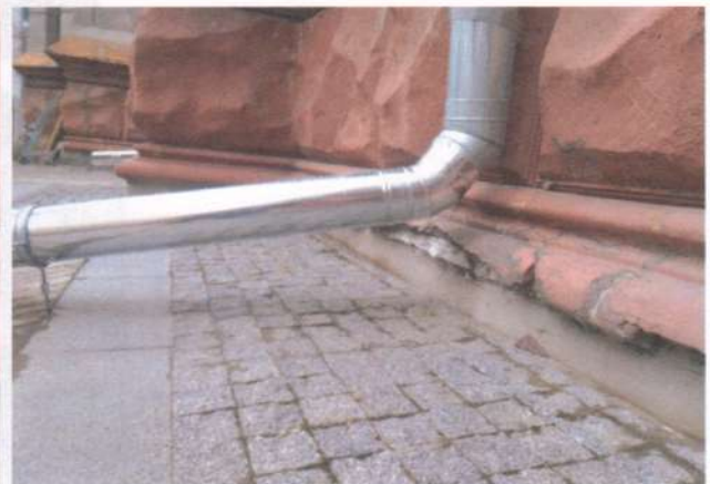
Фото 11. Фасади. Те саме.
