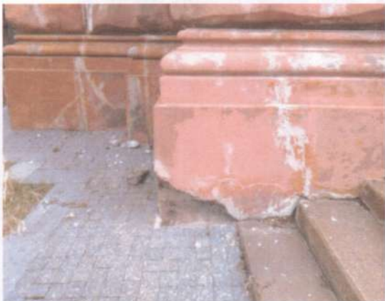
Фото 48. Фасади. Те саме.
