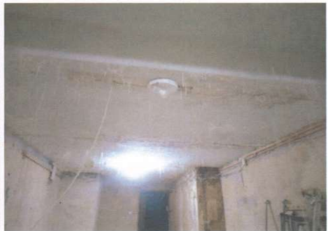
Фото 27, 28. Підвал. Технічне приміщення. Як у печері на стелі краплі мінеральної води, вимиваючи вапно з бетону, утворюють мінеральні виступи — сталактити, що обумовлює корозію бетону та арматури.
