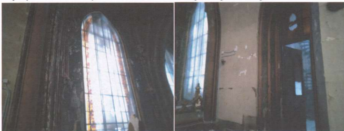
Фото 15, 16. Фотофіксація стану конструкцій другого поверху КСМ свідчить про повне руйнування оздоблення та необхідність термінового виконання відновлювально-реставраційних робіт всіх конструкцій та приведення їх стану в належний вигляд.
