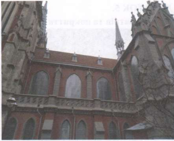
Фото 5. Покрівля, дах. Те саме.
