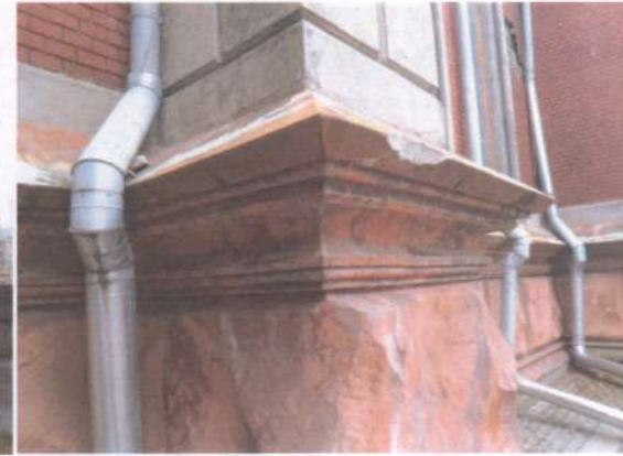
Фото 55. Фасади. Те саме.
