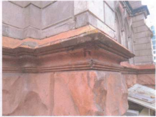
Фото 37. Фасади. Те саме.
