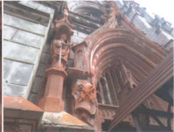
Фото 79. Фасади. Те саме.
