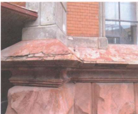
Фото 50. Фасади. Те саме.
