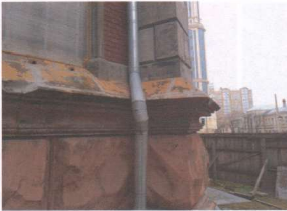
Фото 54. Фасади. Те саме.
