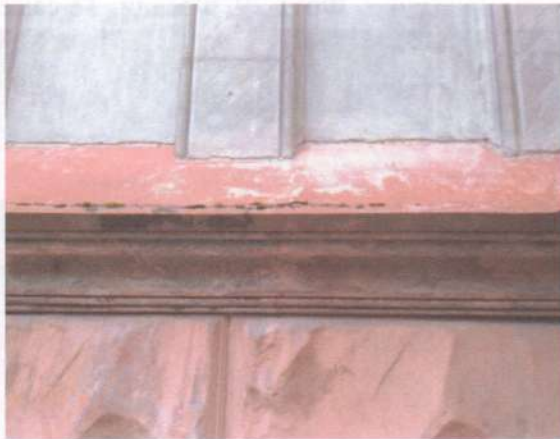
Фото 38. Фасади. Те саме.
