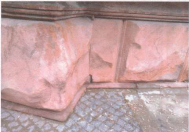
Фото 26. Фасади. Те саме.
