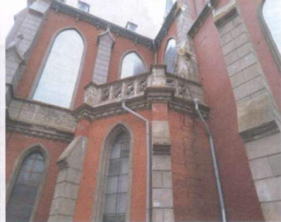
Фото 64, 65. Фасади. Особливого руйнування зазнали великорозмірні віконні конструкції та вітражі і потребують виготовлення нових і їх заміни.
