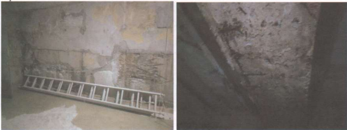
Фото 15,16. Підвал. Технічні приміщення. Після дощу затікання. У вологих умовах корозія бетону та арматури.
