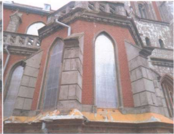
Фото 77. Фасади. Те саме.
