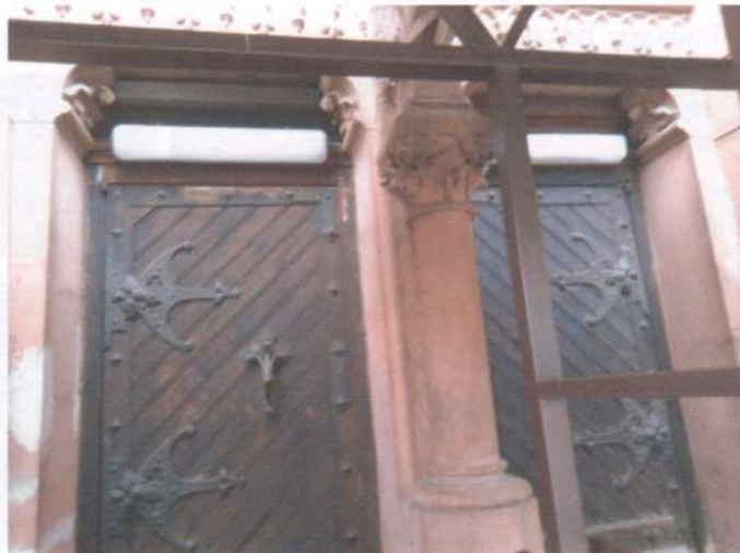
Фото 3. Фасади. Те саме.
