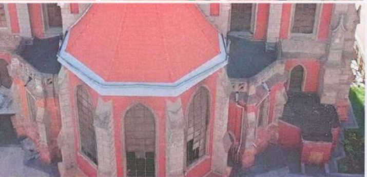
Пошкодження віконних заповнень східної апсиди. Загальний вигляд джерела пожежі зовні. Залишені вітражні вікна повністю зруйновані. Зовнішні стіни з армбаного скла деформовані. Відсутнє скління 3-го поверху (денне вікно), 11 шибок (східне), 6 (північне вікно) апсиди в місці встановлення органу
