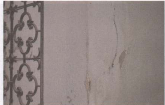
Фото 17, 18. Підвал. Технічні приміщення. Без вентиляції у вологих умовах протягом десятиліть корозія бетону, арматури та електропроводів. Пліснява, тріщини штукатурки, оздоблення та їх осипання.
