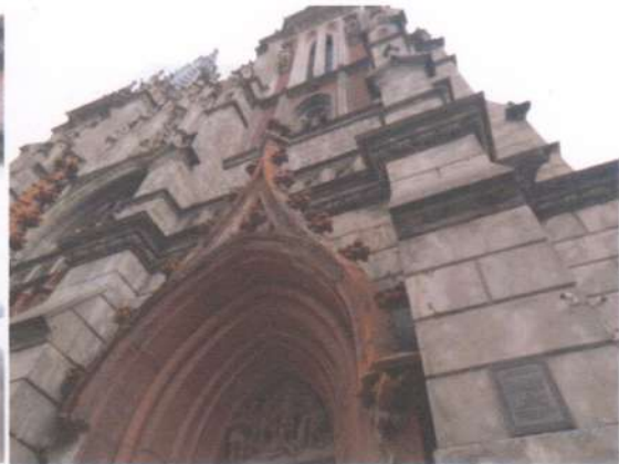
Фото 73. Фасади. Те саме.
