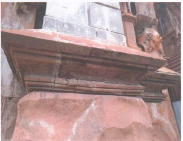
Фото 31. Фасади. Те саме.
