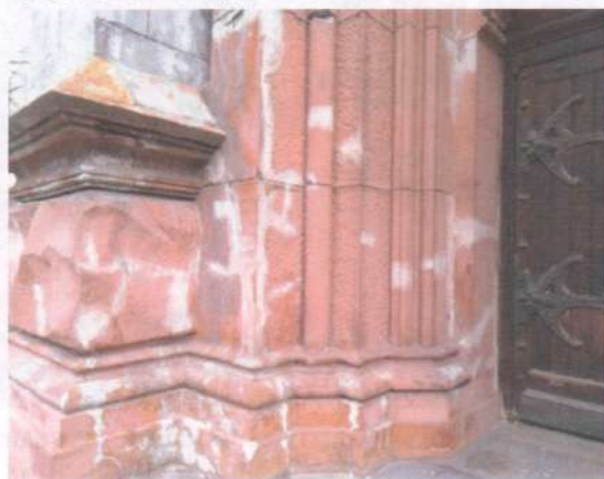
Фото 34. Фасади. Те саме.
