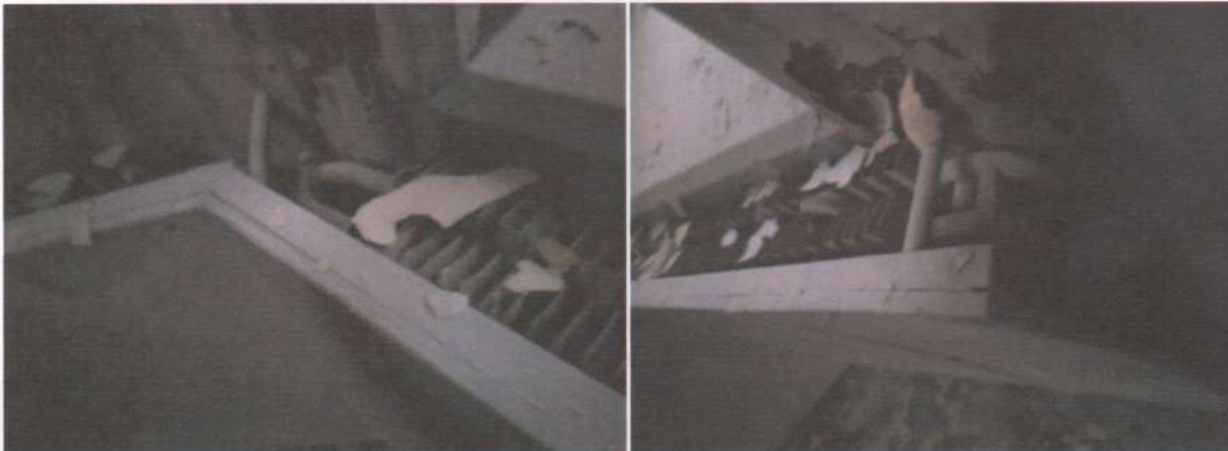
Фото 5, 6. Неefективні «старі» системи опалення необхідно замінити.
