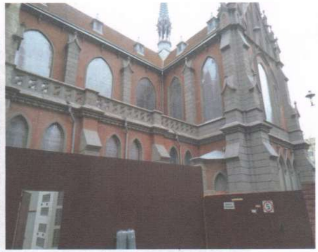
Фото 6. Покрівля, дах. Те саме.
