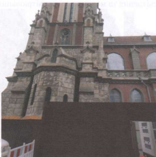
Фото 70. Фасади. Те саме.
