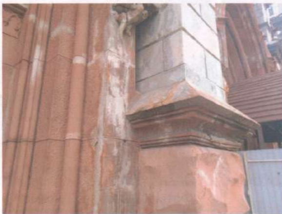
Фото 32. Фасади. Те саме.
