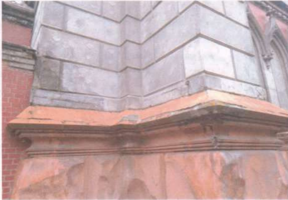
Фото 44. Фасади. Те саме.
