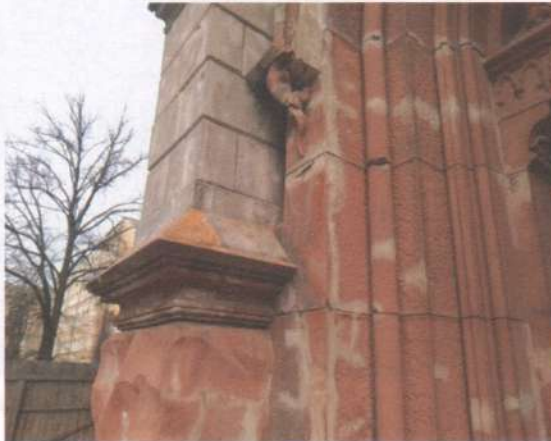
Фото 78. Фасади. Те саме.
