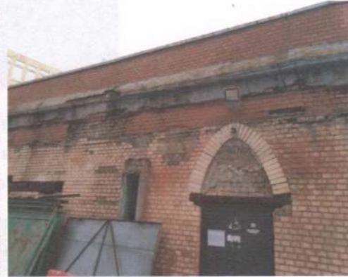
Фото 8, 9. Технічні приміщення. Руйнування фасадів обумовлене низькою якістю використаних матеріалів та відсутністю захисту від дії природних чинників.
