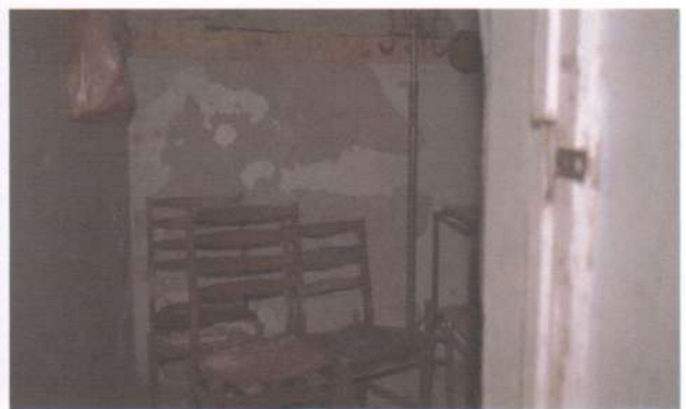
Фото 25, 26. Підвал. Технічне приміщення. При затіканні на протязі десятиліть, тому корозія бетону, арматури, електропроводів, штукатурки та оздоблення. Штукатурка стін та оздоблення потріскались, осипались, або покрилися цвільлю.
