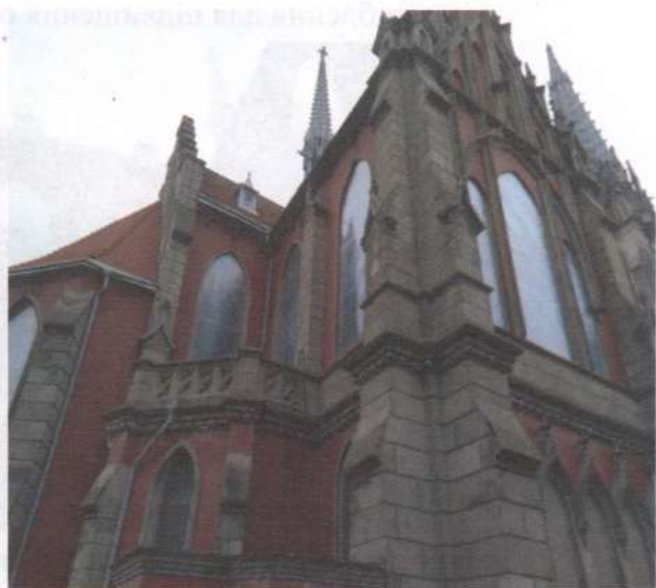
Фото 71. Фасади. Те саме.
