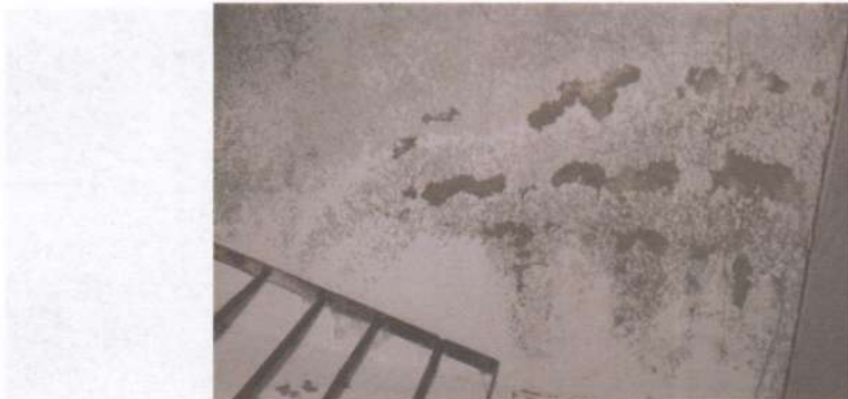
Фото 17, 18. Підвал. Технічні приміщення. Без вентиляції у вологих умовах протягом десятиліть корозія бетону, арматури та електропроводів. Пліснява, тріщини штукатурки, оздоблення та їх осипання.
