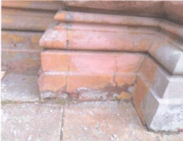
Фото 22. Фасади. Те саме.
