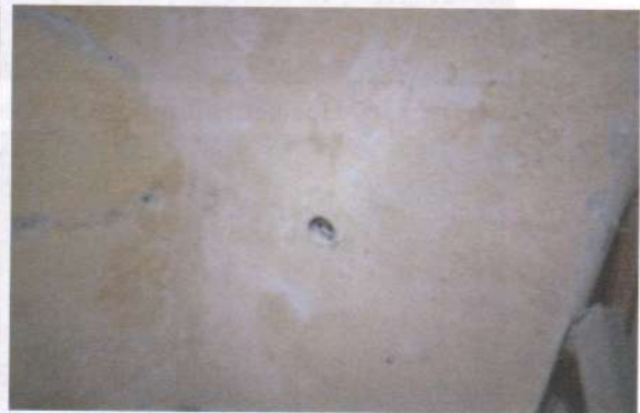
Фото 14, 15. Підвал. Технічні приміщення. При затіканні на протязі десятиліть корозія бетону, арматури, електропроводів, штукатурки та оздоблення. Штукатурка стін та оздоблення потріскались, обсипались, або покрилися цвілью.
