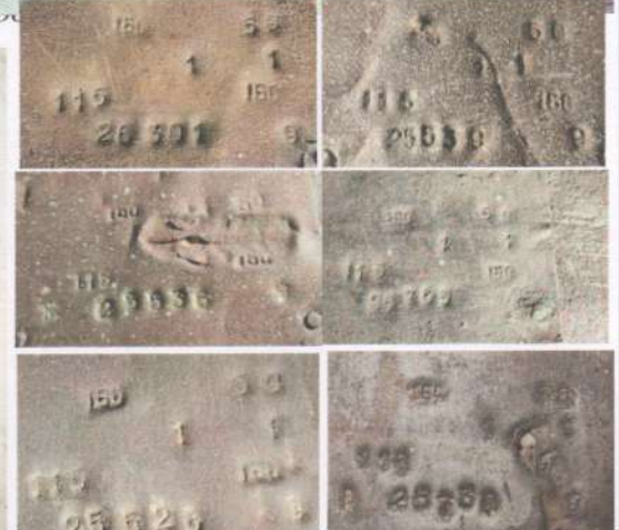
маркування вантажопідійомних пристроїв горища – незареєстрованих ручних лебідок для обслуговування системи освітлення. Паспорти обладнання відсутні. вантажопідійомність їх не встановлена
