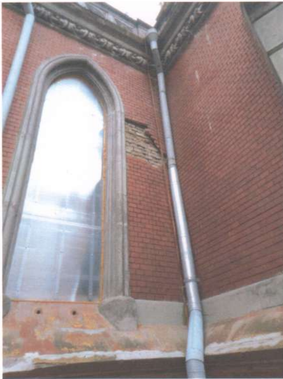
Фото 84. Фасади. Те саме.
