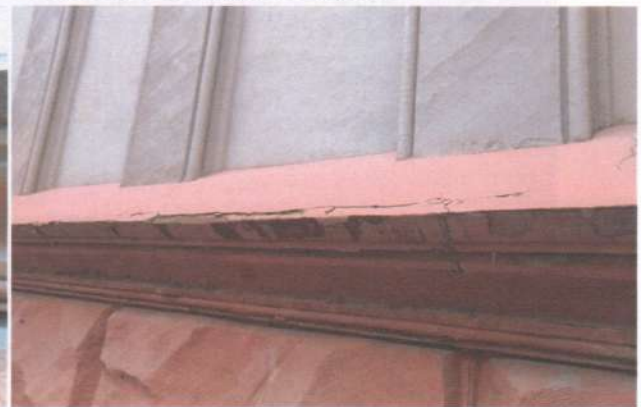
Фото 25. Фасади. Те саме.
