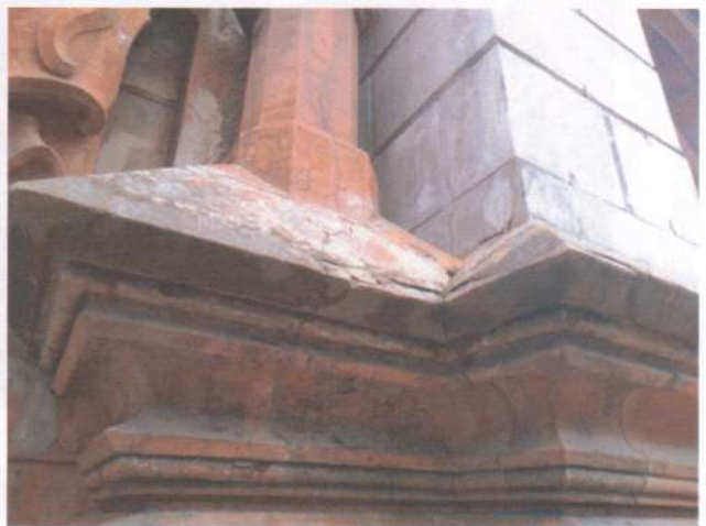
Фото 23. Фасади. Те саме.
