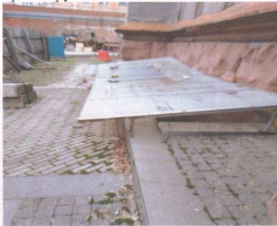
Фото 62, 63. Фасади. Приямки над вікнами підвалів і їх накриття потребують великого обсягу ремонтно-відновлювальних та реставраційних робіт, або суттєвого розширення та заглиблення для підвищення освітлення та можливості провітрювання приміщень.
