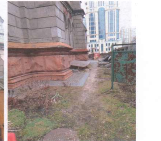
Фото 59. Фасади. Те саме.
