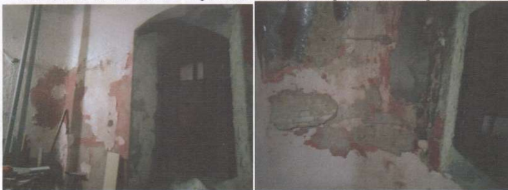
Фото 9, 10. Підвал. Технічні приміщення під центральним вівтарем. Те саме.
