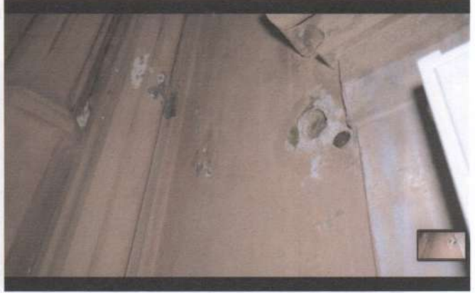
Фото 9, 10. Оздоблення поверхні всіх колон потріскалось, шелушиться та осипається. Місцями штукатурка та бетон потріщали та є випадання кусків тощо.
