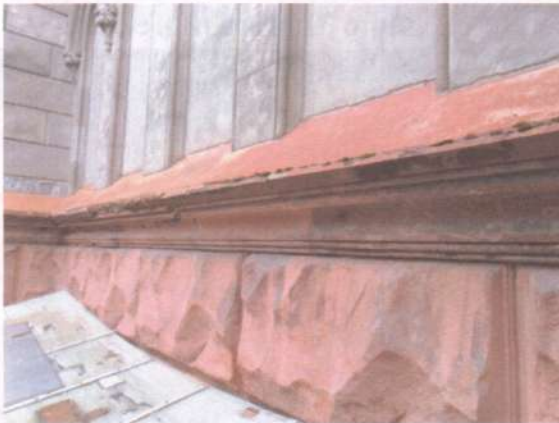
Фото 40. Фасади. Те саме.
