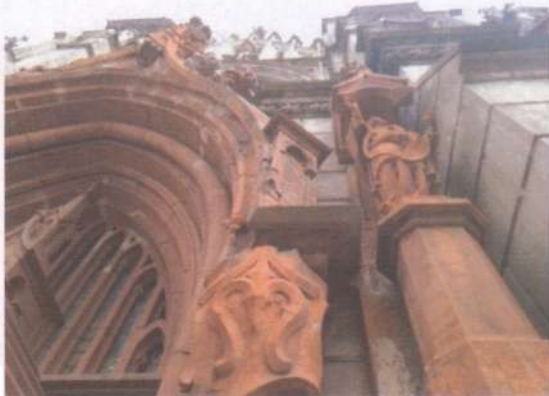
Фото 74. Фасади. Те саме.
