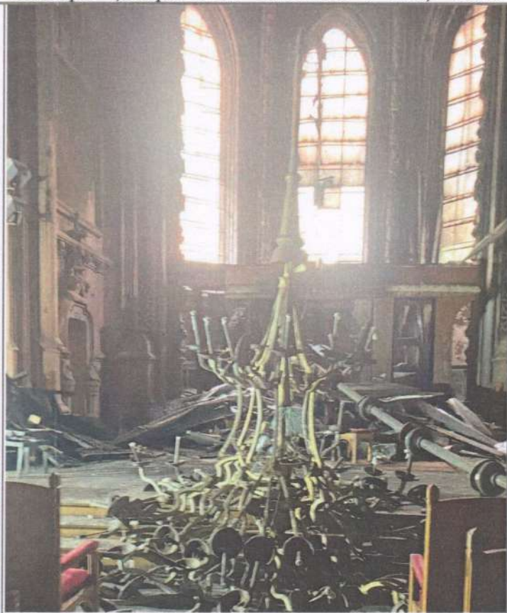
Джерело займання. Вид із глядацької зали на вівтарну апсиду в місці встановлення органу. Залишки декоративних панелей органу, фрагменти трактур, аерофонів та корпусу інструмента у вівтарній частині костелу. На передньому плані зруйнована від пожежі та падіння люстра
