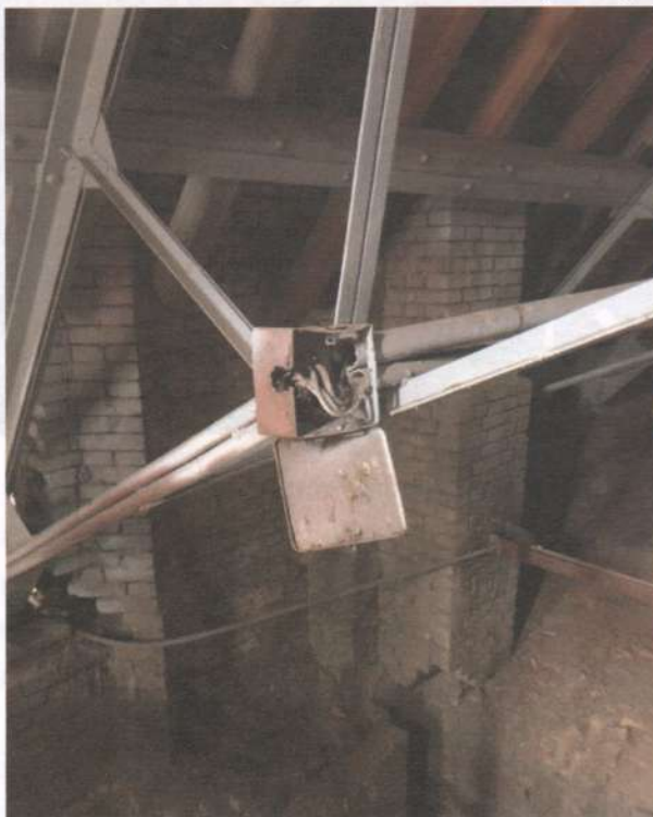
Фото 8, 9. Покрівля, дах. На поверхні перекриття головного залу виявлені дефекти структури, недостатнє опирання цегляних колон, корозію металевих, гниття дерев'яних конструкцій та небезпечний стан електропроводки.
