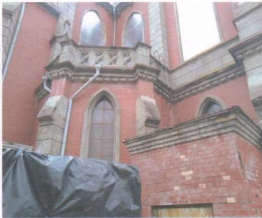
Фото 76. Фасади. Те саме.
