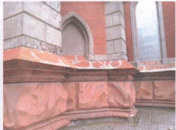
Фото 43. Фасади. Те саме.
