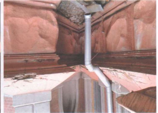
Фото 15. Фасади. Те саме.
