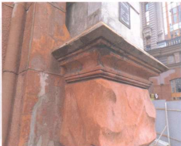
Фото 29. Фасади. Те саме.
