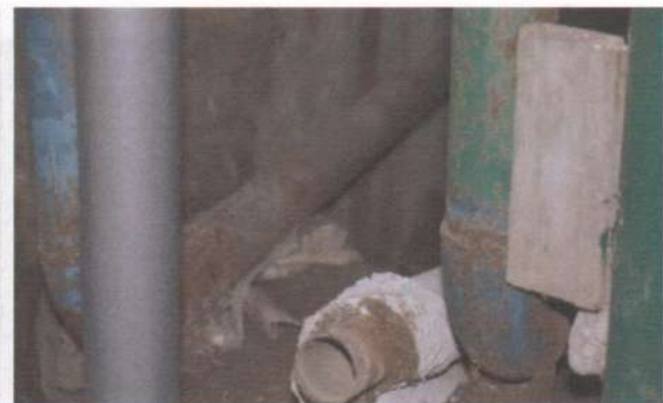
Фото 21, 22. Підвал. Інженерно-технічні системи потребують повної заміни.
