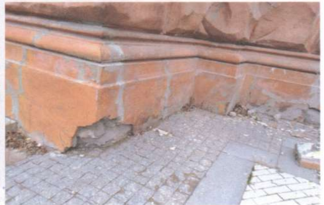
Фото 9. Фасади. Те саме.
