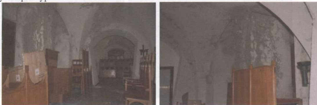
Фото 15,16. Підвал. Технічні приміщення. Після дощу затікання. У вологих умовах корозія бетону та арматури.
