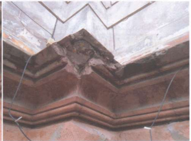
Фото 17. Фасади. Те саме.
