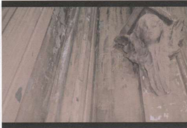
Фото 17, 18. Оздоблення поверхні всіх колон потріскалось, відшаровується та осипається. Місцями штукатурка та бетон потріщали та є випадання кусків бетону тощо.
