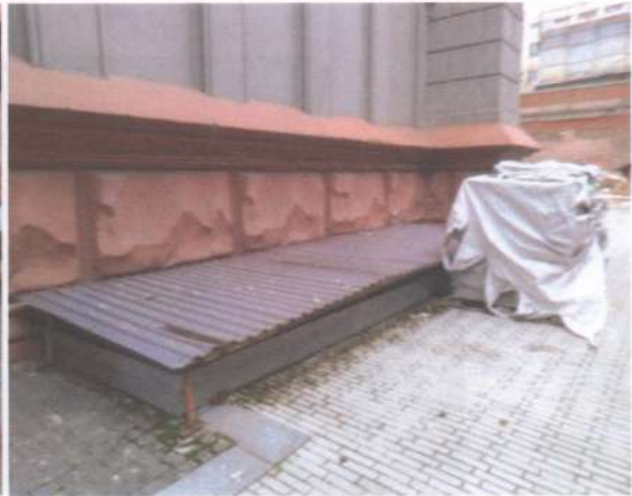
Фото 62, 63. Фасади. Приямки над вікнами підвалів і їх накриття потребують великого обсягу ремонтно-відновлювальних та реставраційних робіт, або суттєвого розширення та заглиблення для підвищення освітлення та можливості провітрювання приміщень.
