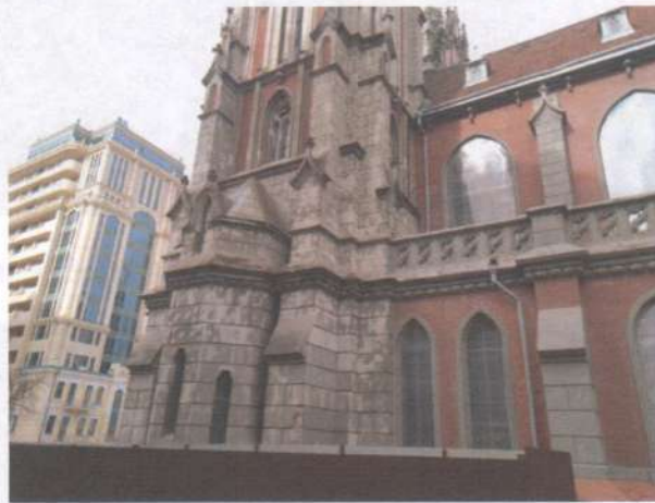
Фото 7. Покрівля, дах. Те саме.
