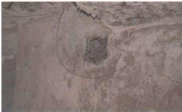
Фото 25, 26. Підвал. Технічне приміщення. При затіканні на протязі десятиліть, тому корозія бетону, арматури, електропроводів, штукатурки та оздоблення. Штукатурка стін та оздоблення потріскались, осипались, або покрилися цвільлю.
