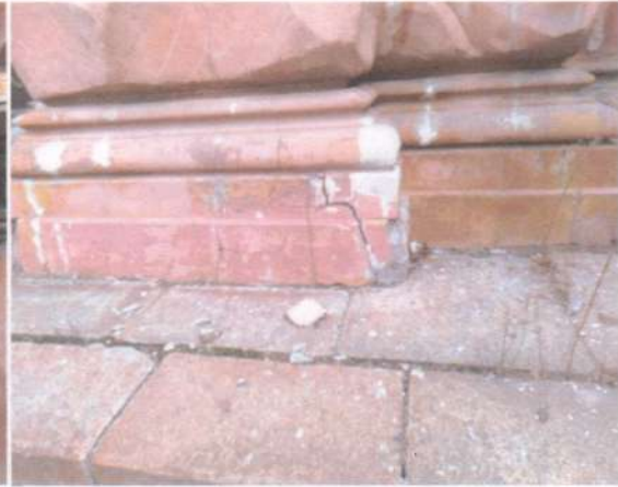
Фото 53. Фасади. Те саме.
