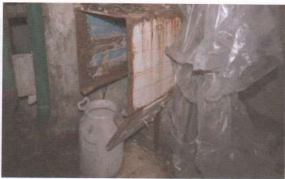
Фото 11, 12. Підвал. Канали вентиляційних систем не працюють. Корозія арматури.
