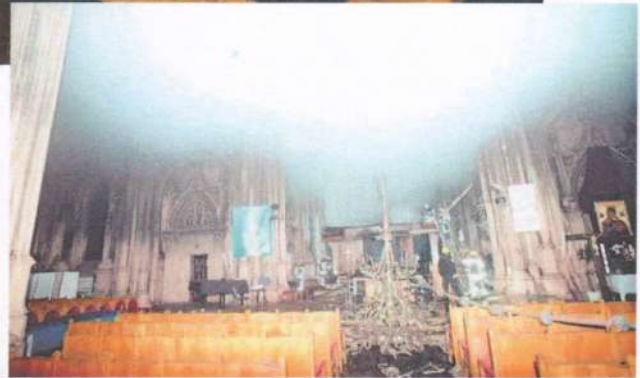
Пошкодження дерев'яних конструкцій сцени та паркетної підлоги від вогню та води при гасінні пожежі. Задимлення, пара, сажа та кіптява у приміщеннях зали. Люстра центрального склепіння в місці свого
