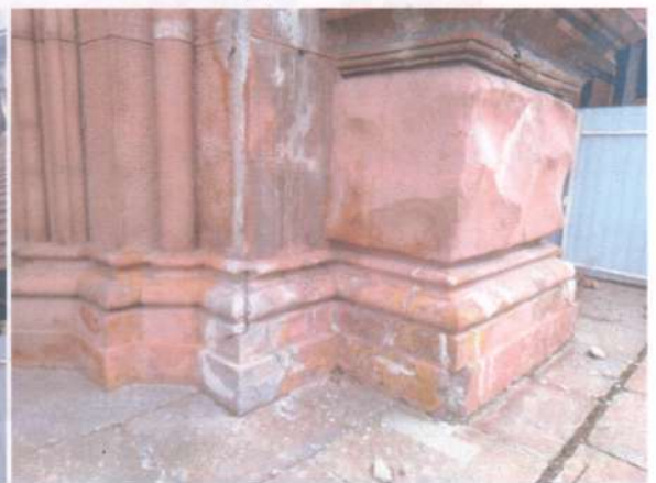
Фото 33. Фасади. Те саме.
