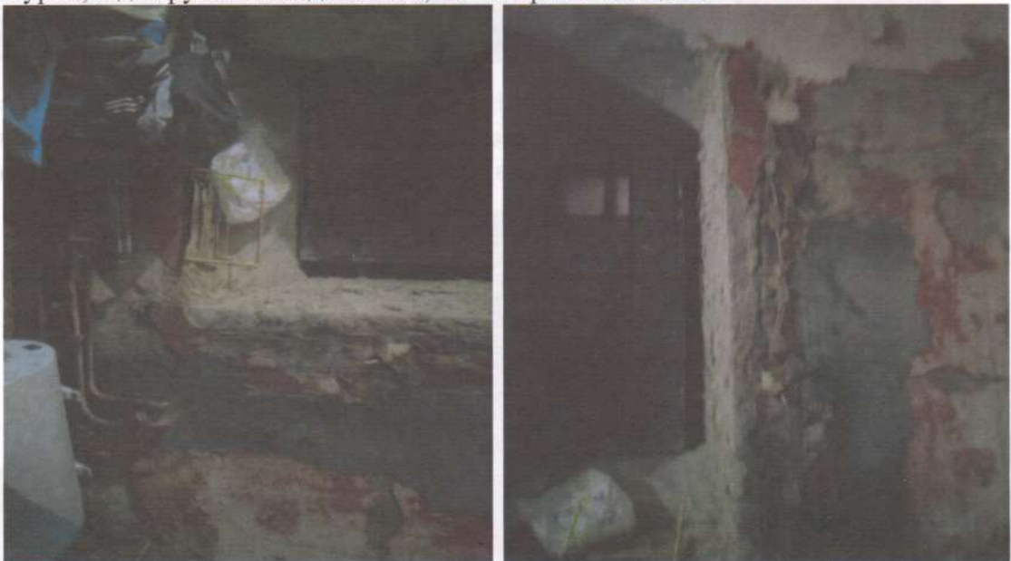
Фото 7, 8. Підвал. Технічні приміщення під центральним вівтарем. Те саме.
