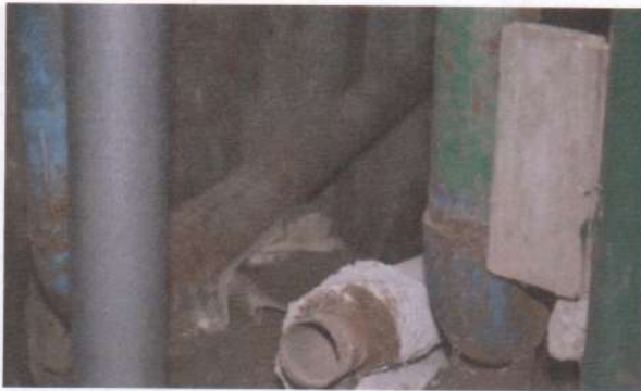
Фото 9, 10. Підвал. Інженерно-технічні системи потребують повної заміни.
