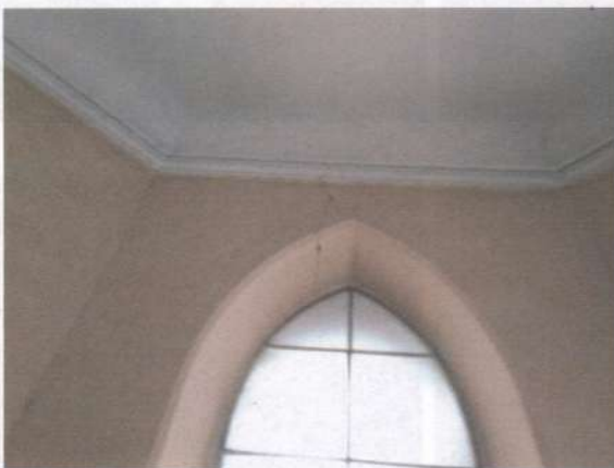
Фото 24, 25. Конструкції другого поверху. Перекриття стрілчатих вікон у найвищій (найслабшій) частині, можливо через дії динамічних навантажень при русі потягів метрополітену, мають тріщини, руйнуються і потребують підсилення.
