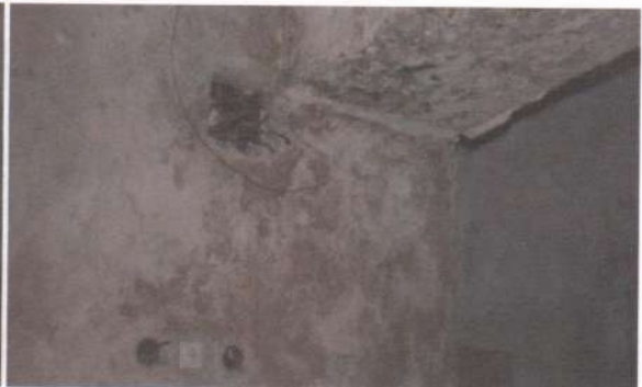
Фото 11, 12. Підвал. Канали вентиляційних систем не працюють. Корозія арматури.
