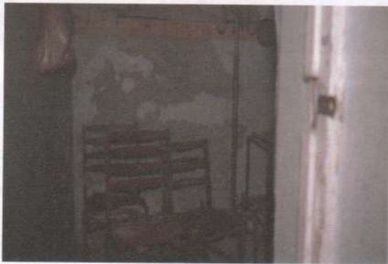
Фото 14, 15. Підвал. Технічні приміщення. При затіканні на протязі десятиліть корозія бетону, арматури, електропроводів, штукатурки та оздоблення. Штукатурка стін та оздоблення потріскались, обсипались, або покрилися цвілью.
