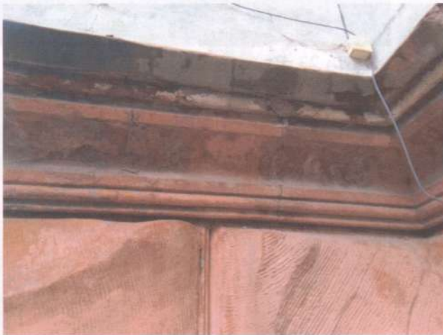
Фото 16. Фасади. Те саме.
