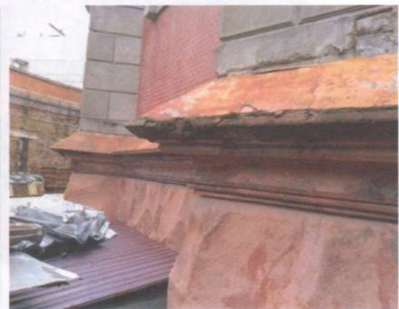
Фото 35. Фасади. Те саме.
