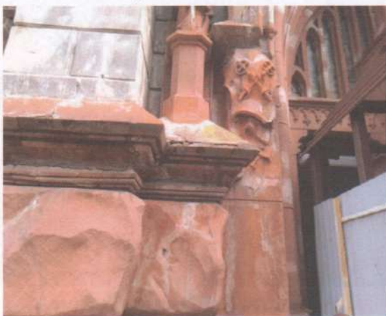
Фото 30. Фасади. Те саме.
