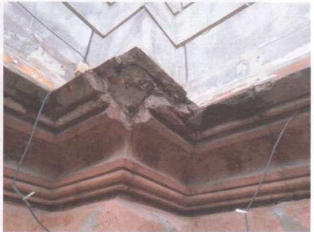
Фото 21. Фасади. Те саме.
