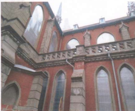
Фото 64, 65. Фасади. Особливого руйнування зазнали великорозмірні віконні конструкції та вітражі і потребують виготовлення нових і їх заміни.
