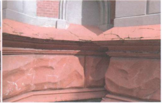
Фото 13. Фасади. Те саме.
