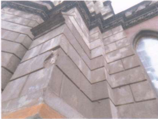
Фото 72. Фасади. Те саме.
